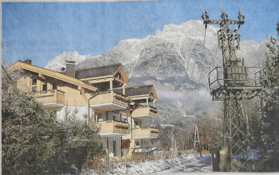
• Een penthouse in het idyllische dorpje Leogang met uitzicht op een machtige bergflank. Eigenaar Harreman mag er niet meer wonen, op straffe van een boete.
